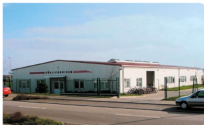
PÜPLICHHUISEN Kabeltechnik GmbH Produktionsstandort in Sömmerda
